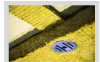
Putsfäste monteras genom isolerputsskivan och distansremsan
