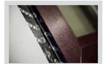
Tätningstejp runt fönster
