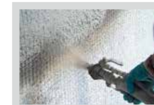
Sprutning av underlagsbruk
