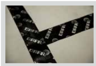
Överlappning vid horisontella och vertikala mötet
