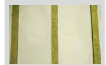
Montering av distansremsa
