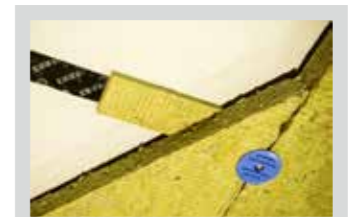
Montage av isolerputsskiva
