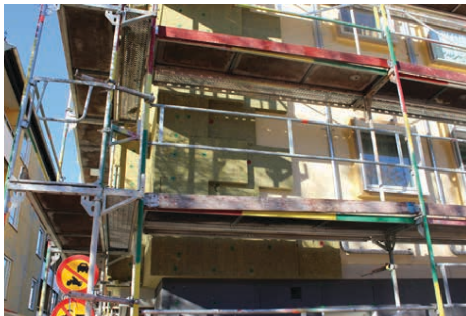
Figur 3. Ventilationskanaler monterades direkt på den befintliga fasaden och utanför dessa monterades isolering och puts.
