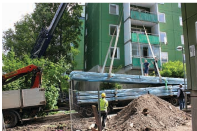
Figur 1. Montage av prefabricerade element skedde med kran.
