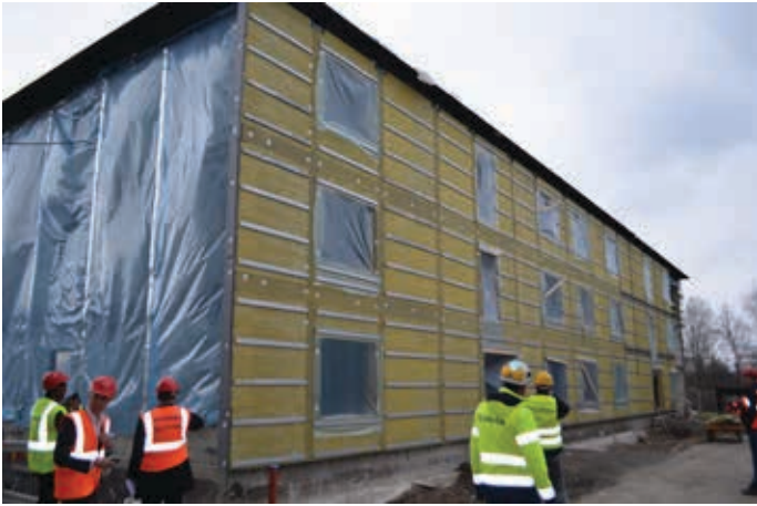
Figur 2. Brogården under montage av prefabricerade väggelement.
